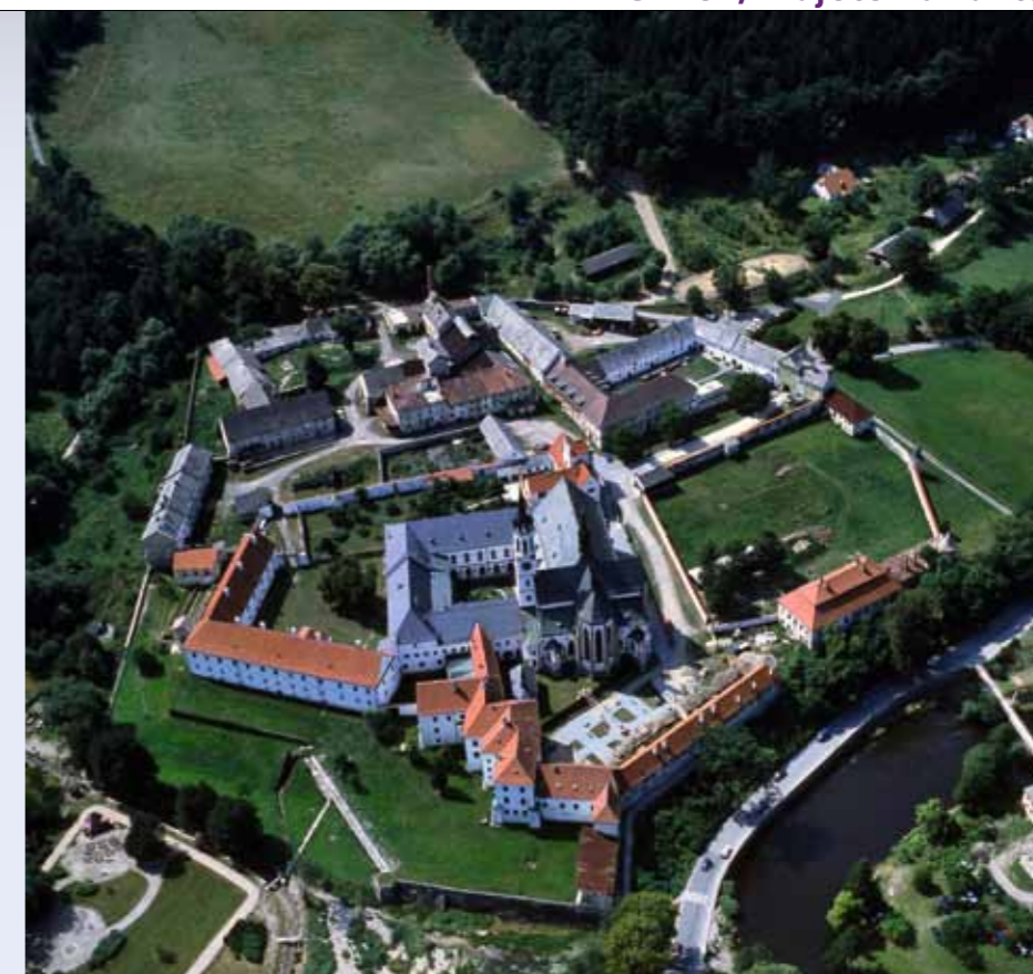
Cisterciácký klášter ve Vyšším Brodě
