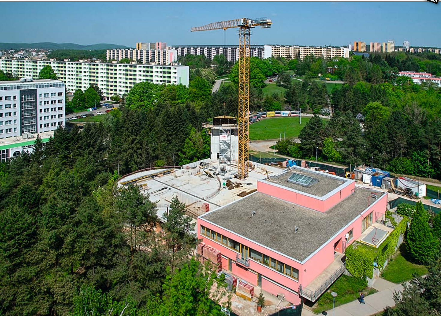
Pohled z ptačí perspektivy na stávající budovu duchovního centra v Brně-Lesné se stavenišťem nového kostela
