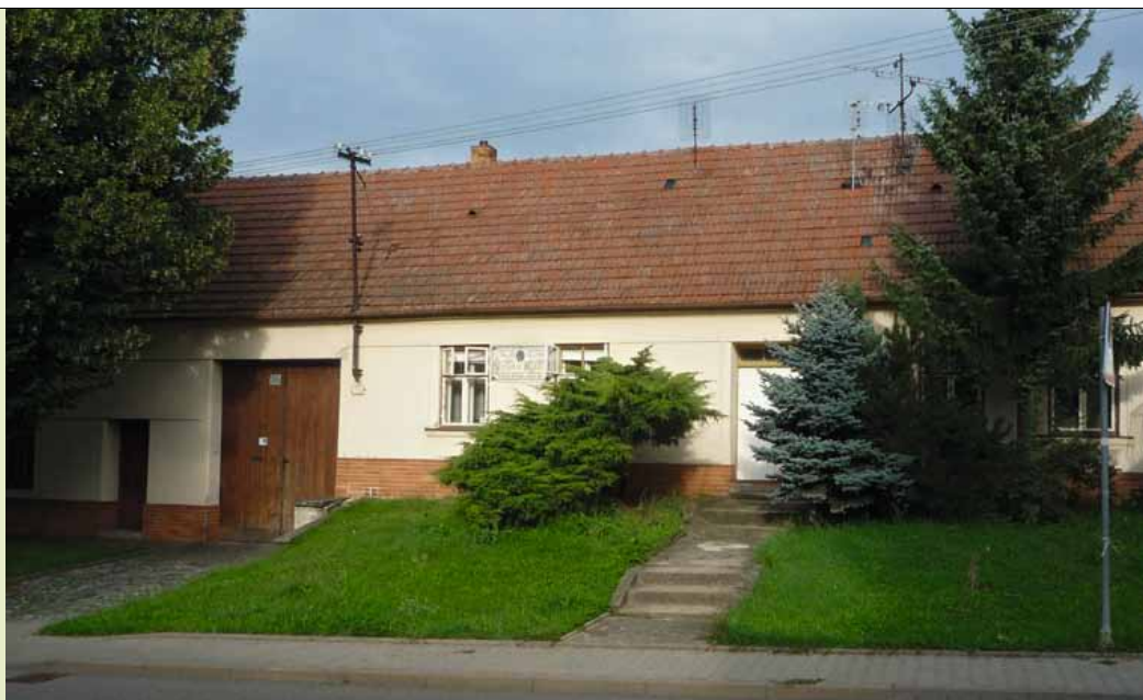
Současná podoba Kubínkova rodného domu v Blažovicích
